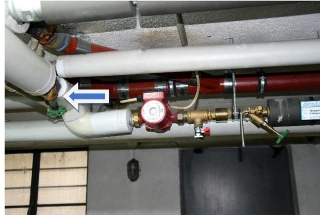
**Mangel:** Falsch installiertes Probenahmeventil (PWH-C)
